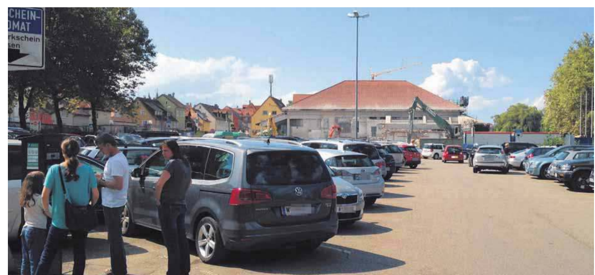
Voraussichtlich noch zwei Wochen lang bleibt der Parkplatz neben der Inselhalle. Übrigens: Der frühere Schlauchturm der Feuerwehr war am Freitagmittag bereits komplett abgetragen.
